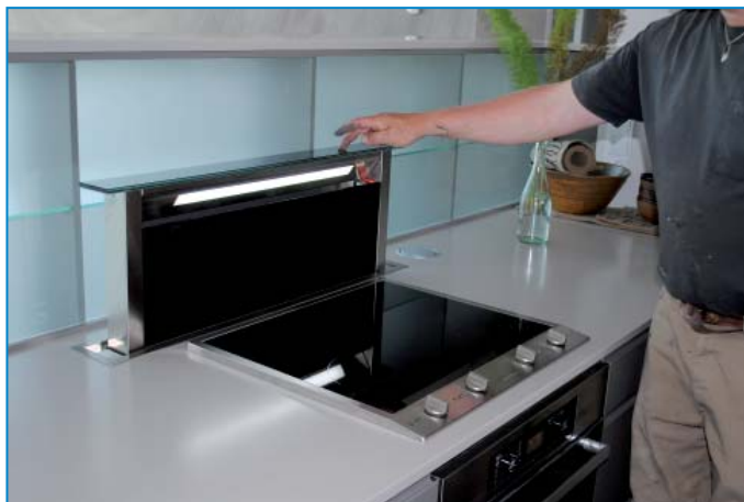
Keittiön ja olohuoneen jakaa seinäke, jonka taakse on kätkeytyä ylösnouseva liesituuletin. Kuva: Heli Mäntylä
